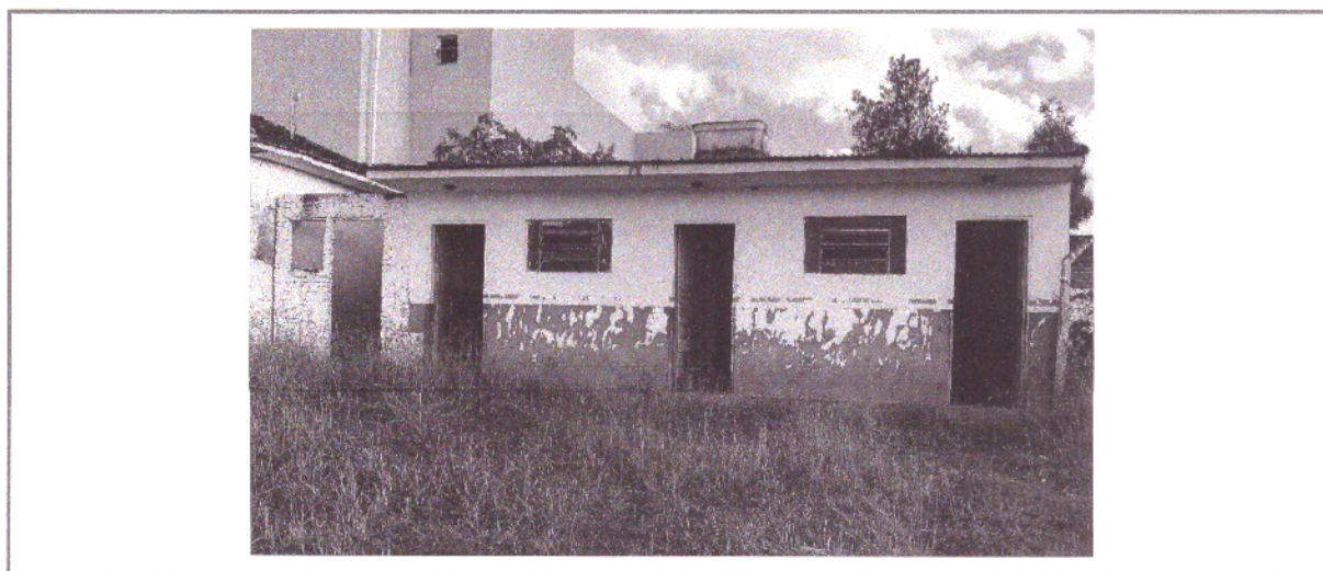
Figura 2 – Fachada dos vestiários
