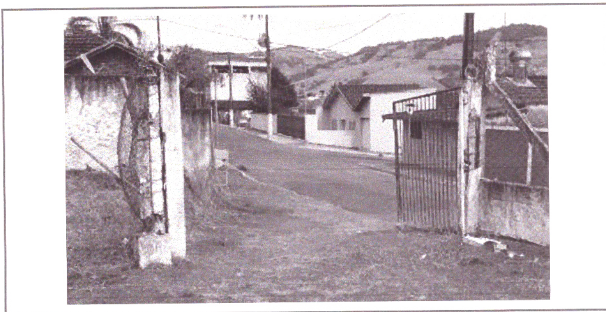
Figura 9 – Pilares do portão
